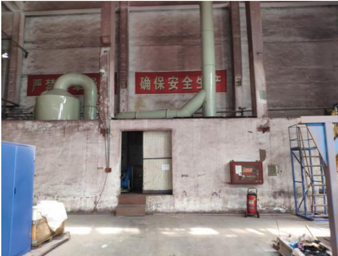
图3-3 碱液吸收塔及排气筒照片
