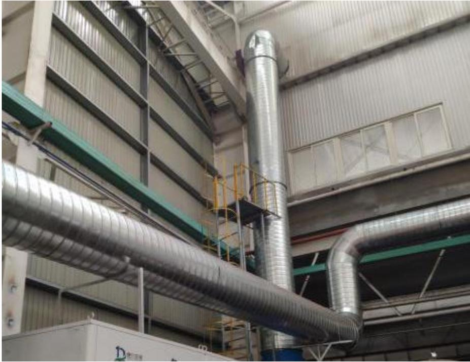
图3-2 废气取样平台及取样口照片
